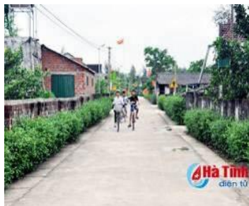
Đường bê tông, rãnh thoát nước 2 bên đường có nắp đậy kín
